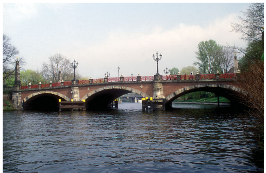
Bild 3. Lutherbrücke Berlin Fig. 3. Luther Bridge Berlin
