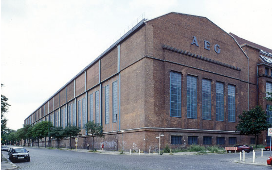
Bild 13. AEG-Montagehalle Fig. 13. AEG-Assembling Hall
