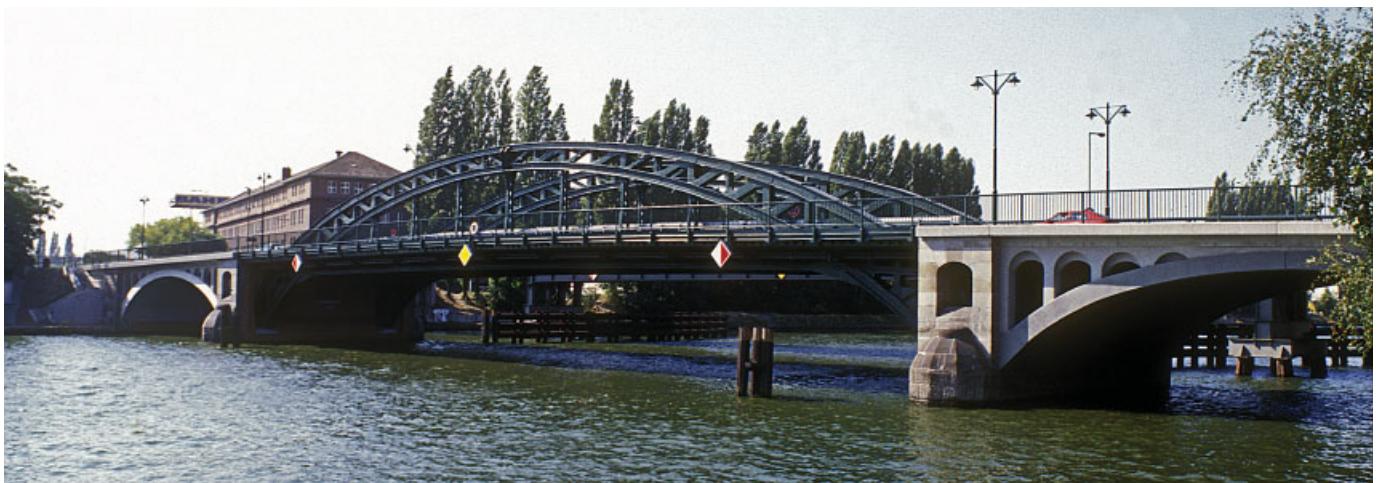
Bild 8. Stubenrauchbrücke Berlin Fig. 8. Stubenrauch Bridge Berlin
