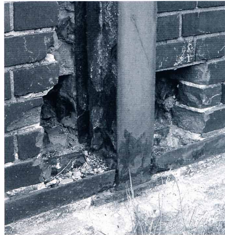
Abb. 20 Korrosionsschaden bei nichtbündiger Ausführung von Stahlprofil und Mauerwerk bei Fachwerkänden
