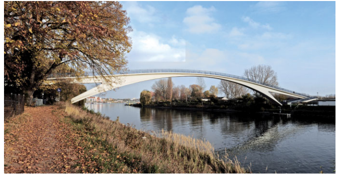
Bild 20 Schiersteiner Steg 1967 Footbridge in Schierstein
