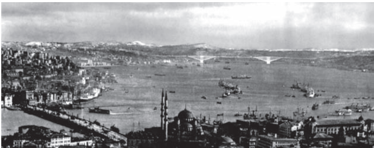
Bild 36: Spannbandbrücke über den Bosphorus
