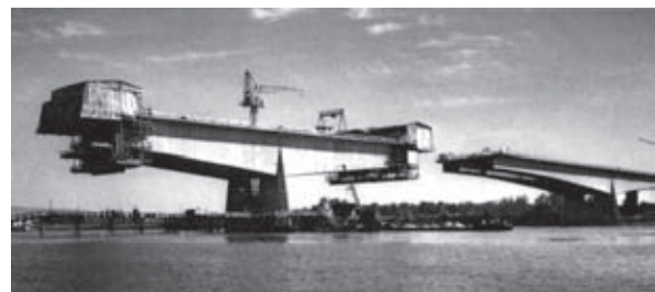
Bild 27: Freivorbau der Brücke Bendorf
