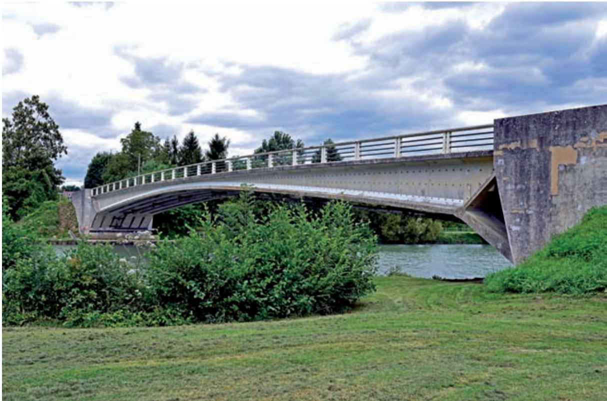
Bild 14: Freyssinet-Brücke in Changis-sur-Marne, erbaut 1950
