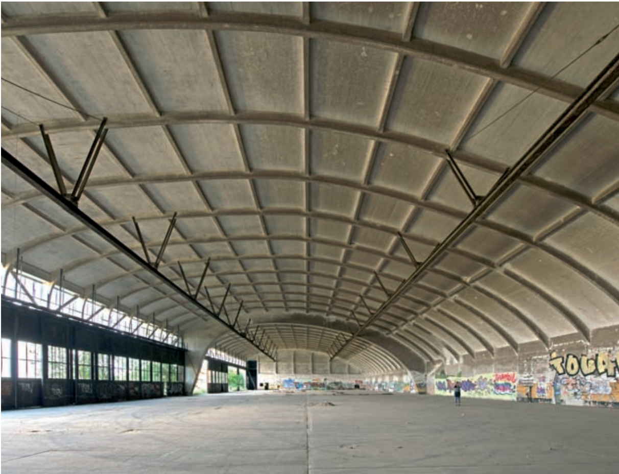
Bild 7: Flugzeughalle in Werneuchen
