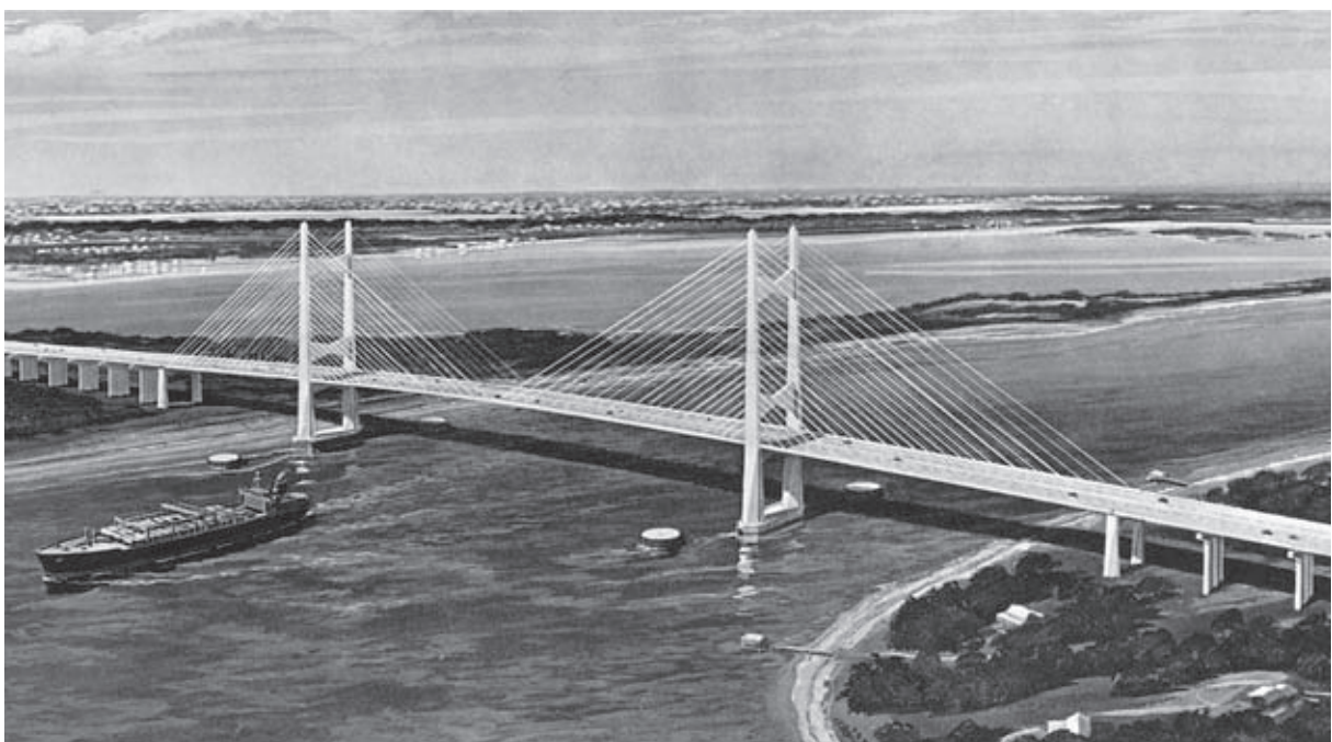
Bild 41: Dames Point Bridge Florida
