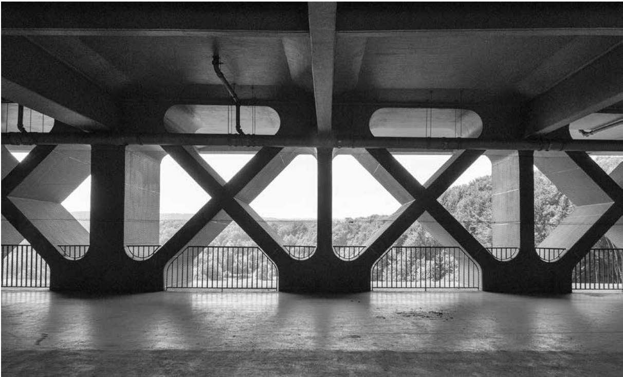
Bild 13 Mangfallbrücke, Ebene für Fußgänger und Radfahrer
