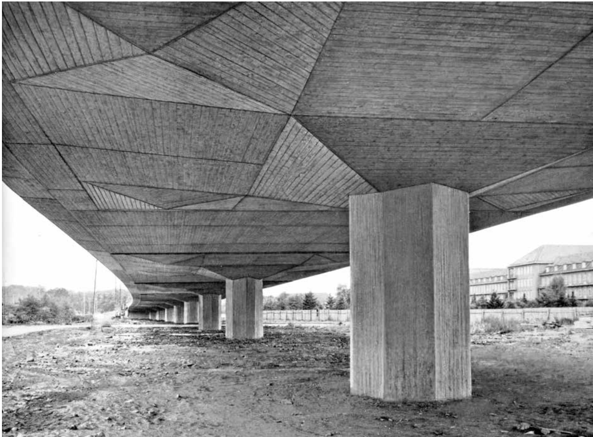
Bild 23 Hochstraße Stadtfelddamm Hannover
