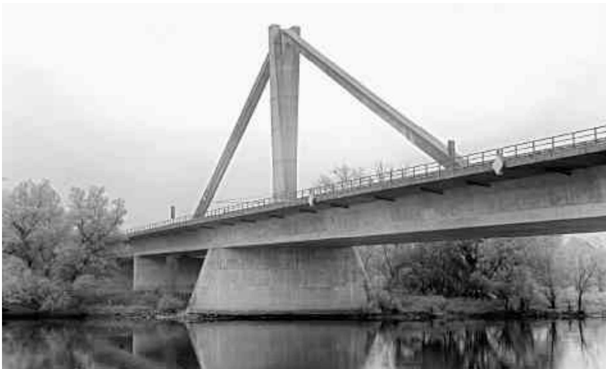
Bild 23 Donaubrücke Metten mit Zügelgurt
