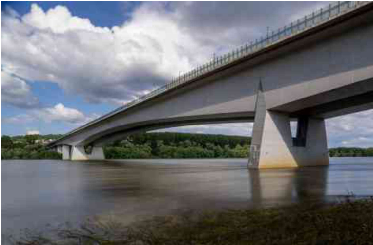
Bild 12 Rheinbrücke Bendorf: Der elegante Entwurf von Finsterwalder, Schambeck und Lohmer war nicht nur die preisgünstigste Lösung, sondern hielt auch den Weltrekord als weitest gespannte Betonbalkenbrücke Foto: C. Dicleli (2021)
