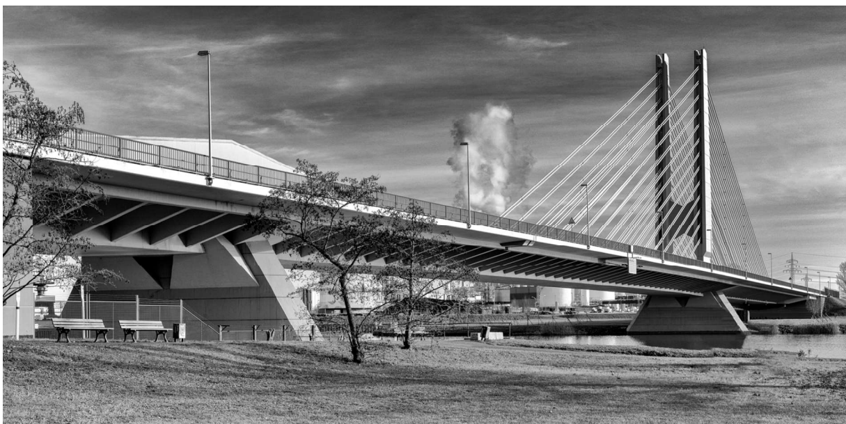
Bild 17 2. Mainbrücke der Hoechst AG
