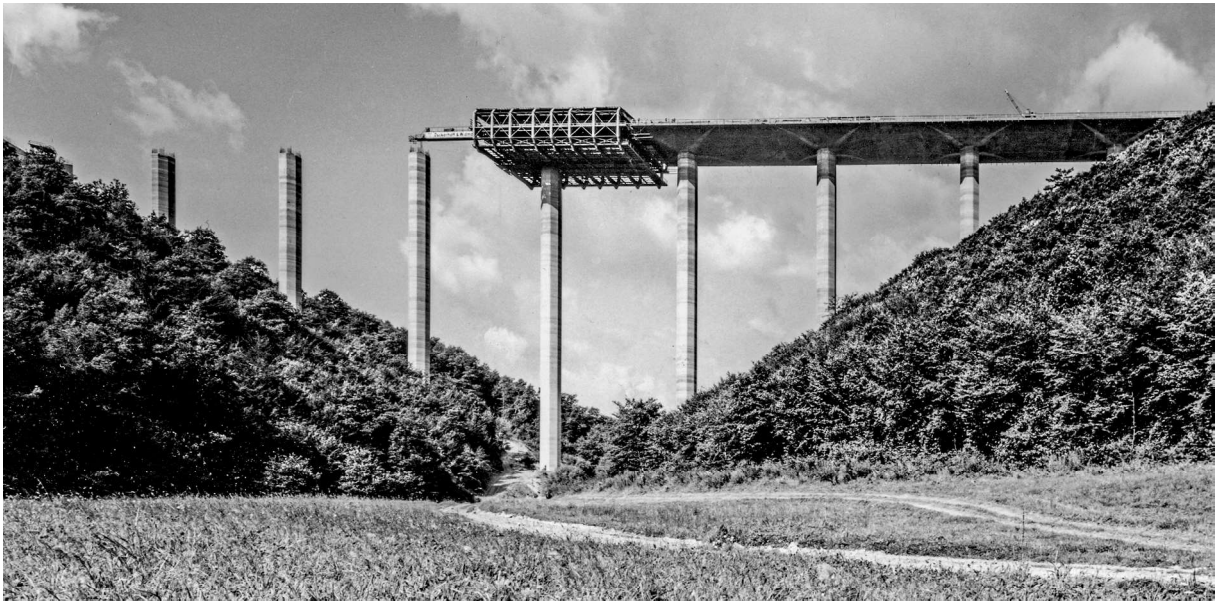
Bild 14 Der Bau der Elztalbrücke mit dem Dywidag-Vorschubgerüst als „Fabrikationshalle“
