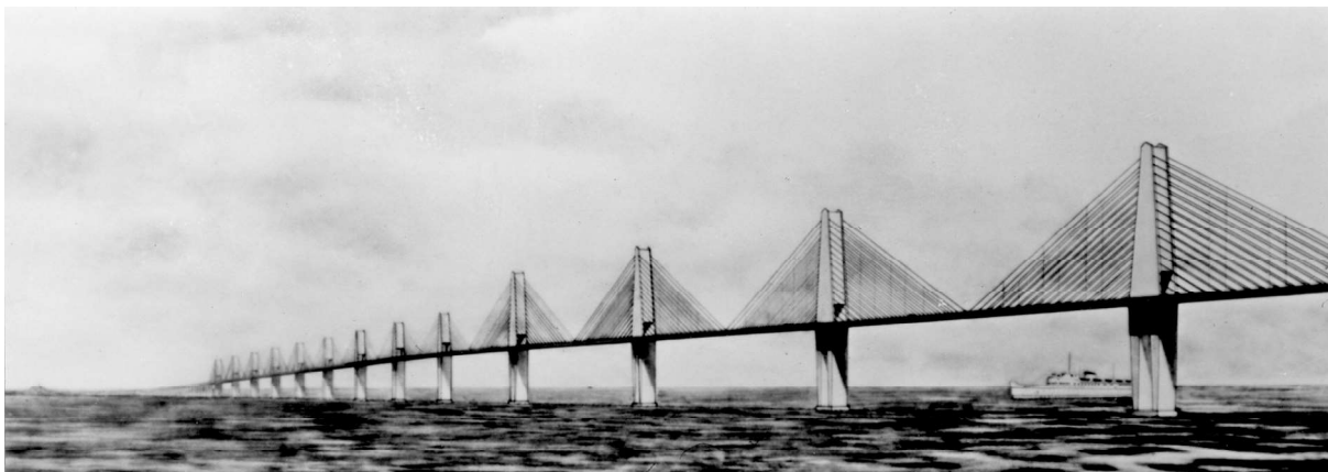
Bild 6 Wettbewerb Brücke Großer Belt: der Vorschlag von Dyckerhoff & Widmann war eine Reihe von Schrägseilbrücken [17] Foto: Werkfoto D&W
