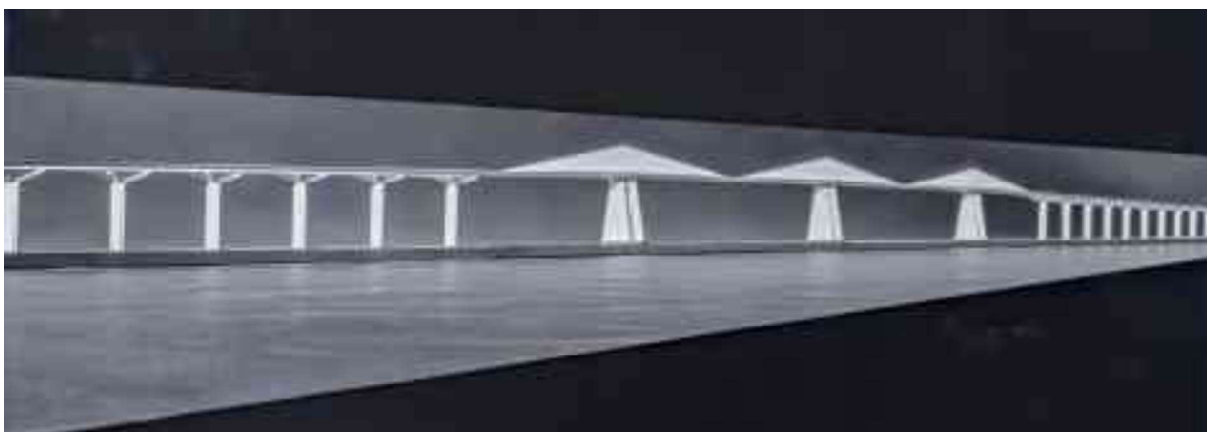
Bild 7 Wettbewerb Brücke Großer Belt, Vorschlag Herbert Schambeck: Pilzbrücke mit Betonsegeln für die großen Öffnungen Foto: Privatarchiv Schambeck (PASch), Photo-Anker, München
